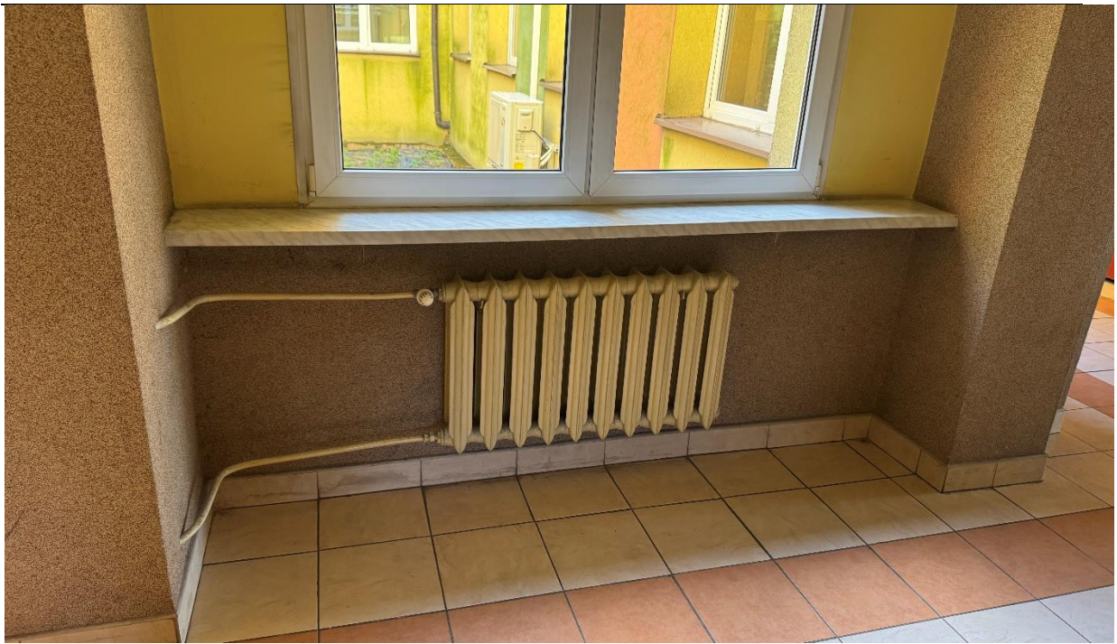
Grzejnik żeliwny członowy w układzie grzewczym budynku.
