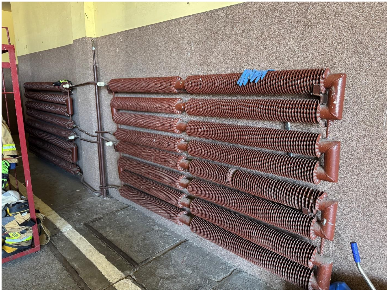
Grzejnik stalowy ożebrowany w układzie grzewczym budynku.
