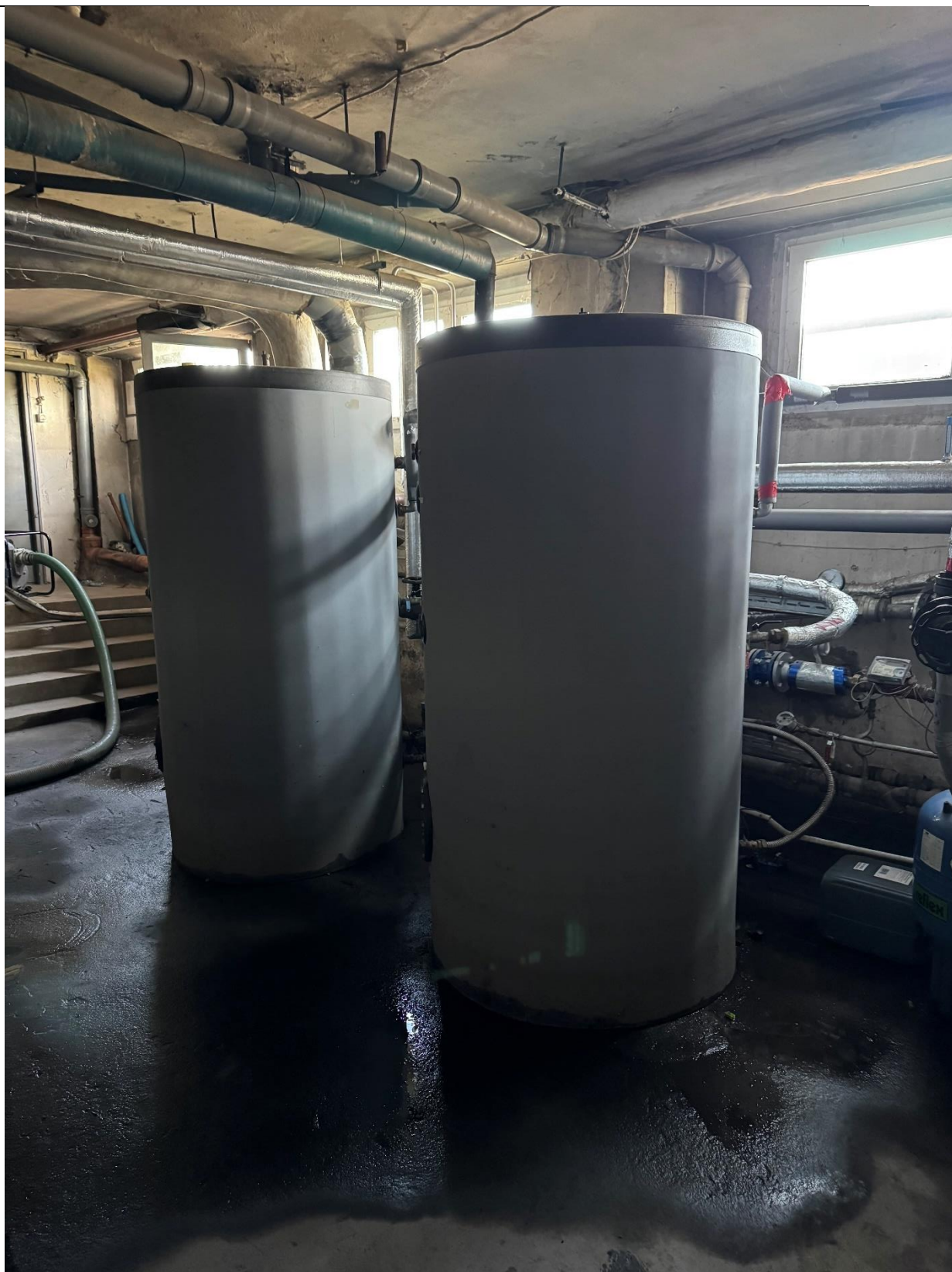
Zasobniki układu solarnego.
