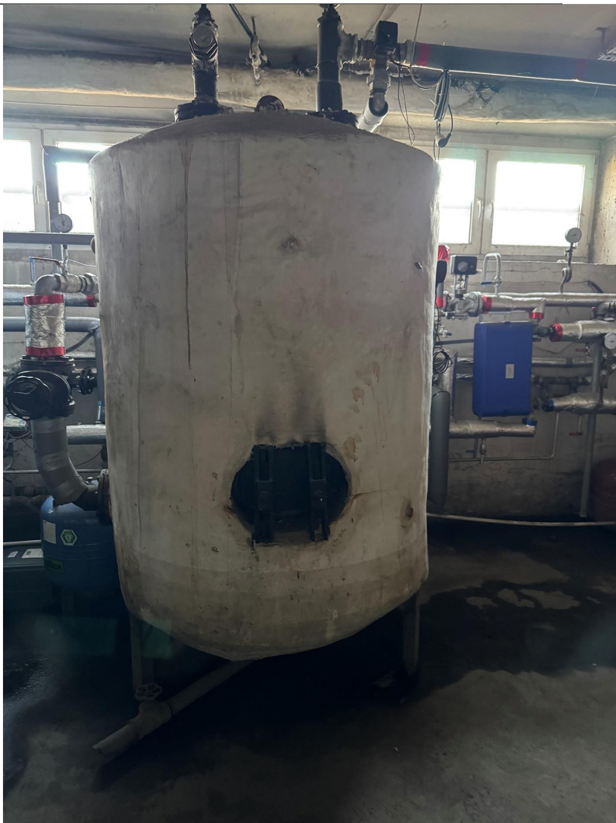
Zasobnik cwu w węźle cieplnym - do wymiany.
