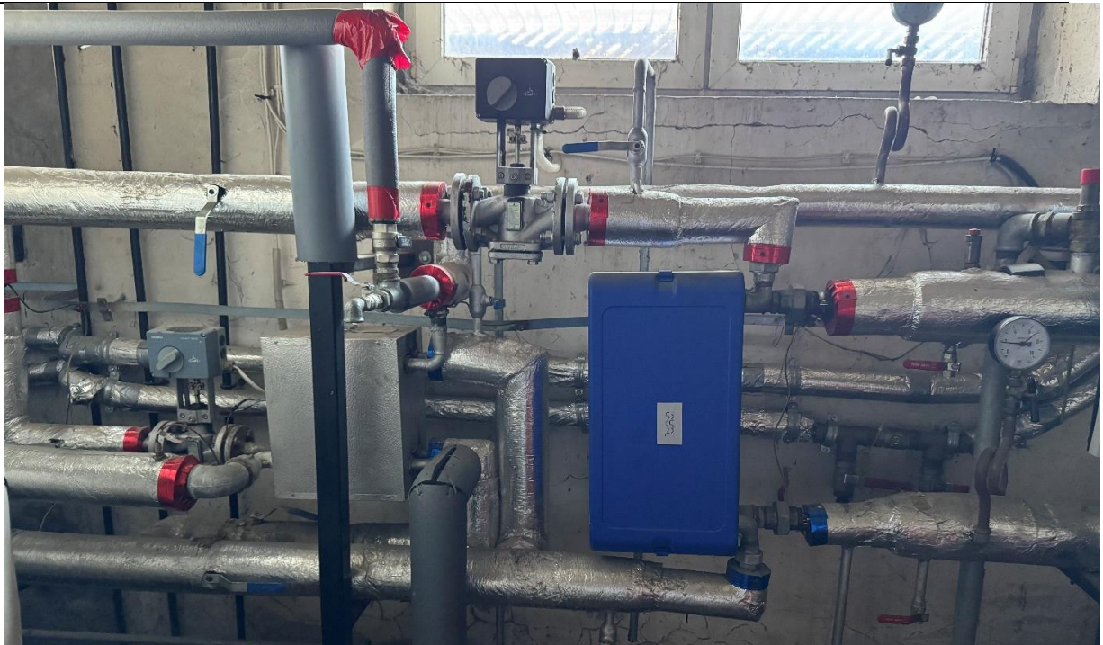
Źródło ciepła - węzeł ciepłowniczy.
